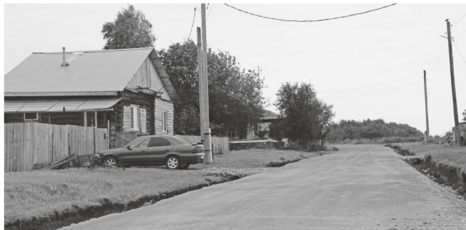
Отремонтированная улица Набережная. Фото А. БАХТИНА.
